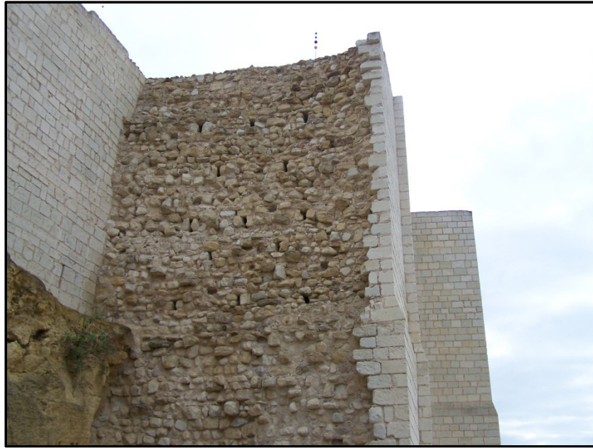
Abriss einer Wandschale, Burg Chinon, Frankreich. Hier reichte schon das Eigengewicht.
